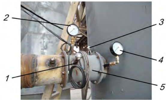
1, 3 – давач температури; 2, 4 – манометр; 5 – багатосопловий пристрій
