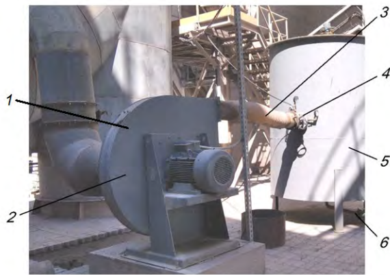
1 – джерело димових газів; 2 – вентилятор; 3 – труба; 4 – багатосопловий пристрій; 5 – буферна камера; 6 – штуцер
