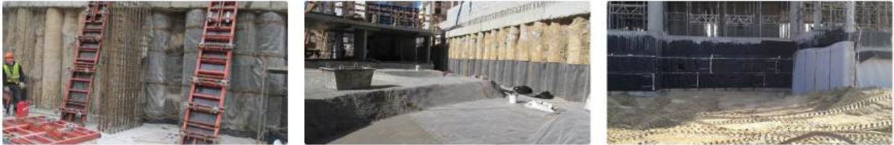
Рисунок 1. Приклади робіт з герметизації конструктивів будівель та споруд
