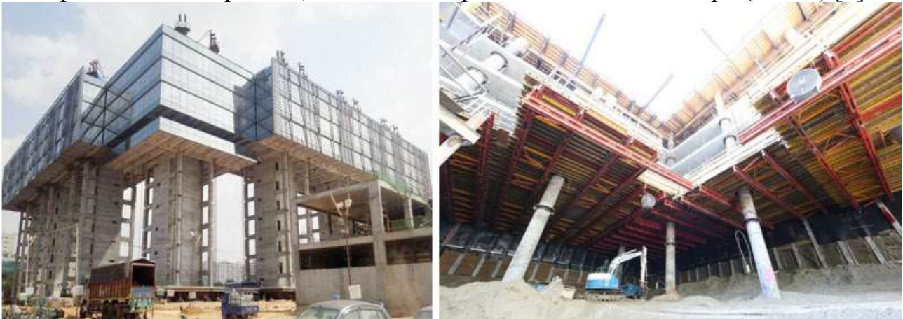
Рисунок 1. Приклади будівництва конструкції «зверху вниз»
