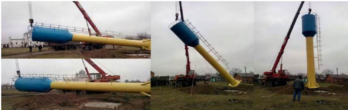
Рисунок 3. Монтаж водонапірної вежі, на прикладі вежі Рожновського
