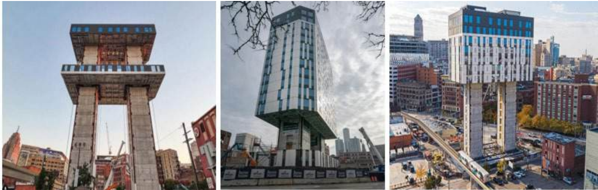
Рисунок 2. Приклади будівництва конструкції «зверху вниз»
